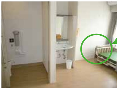
配管 BOX (給排水接続)
