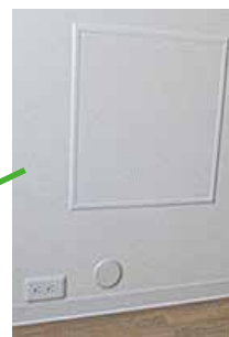
配管 BOX (給排水接続)
