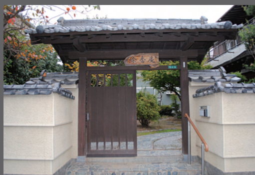
施設門扉に手摺を新設
