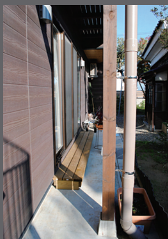
1階居室掃き出し窓とたたきの段差解消のため足台を設置した
