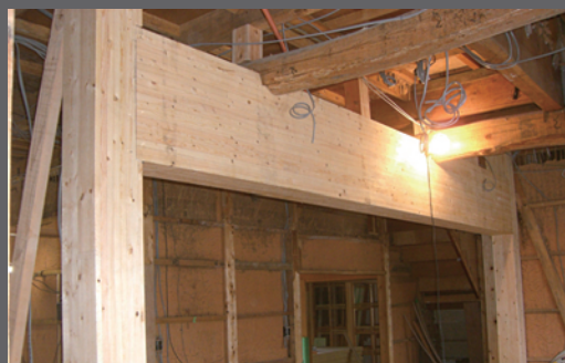
新設した柱と梁
