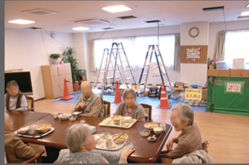
⑥ 昼食時は工事は一時的に中断
