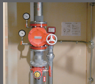
GH 内に設けられた制御弁
