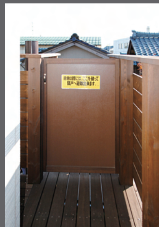
事故防止のためバルコニーから避難階段につながる所に扉をつけた
