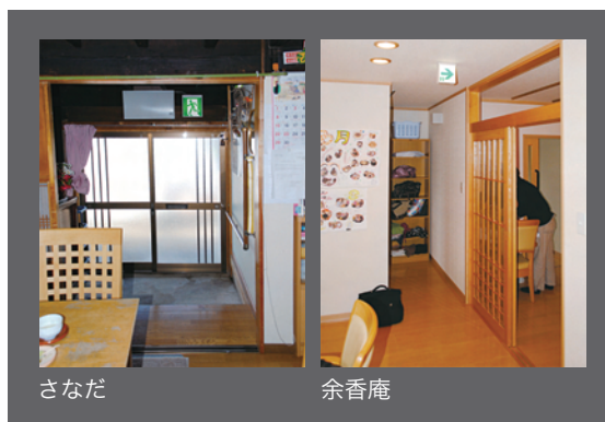
図表 4-5 誘導灯と誘導標識
