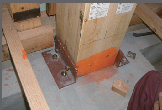
新設した土台と柱の緊結部分
