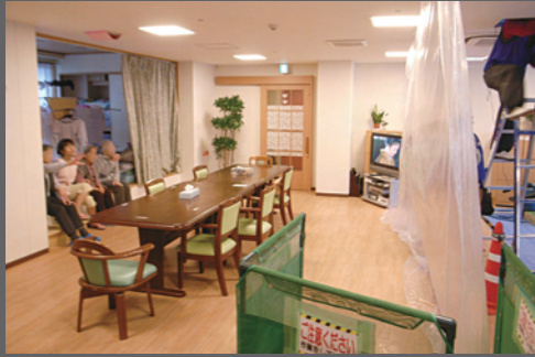
⑤ 工事の様子を見学する利用者
