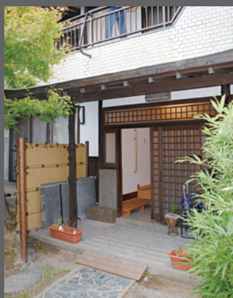
施設玄関、玄関左に立てかけられた鉄板が門扉用スロープ板
