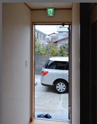
旧勝手口も正式な出入口(通常、送迎車はこちらに寄せる)
