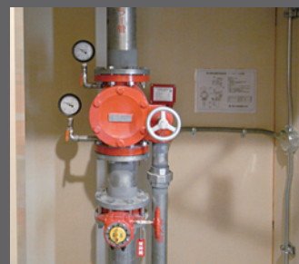
GH 内に設けられた制御弁
