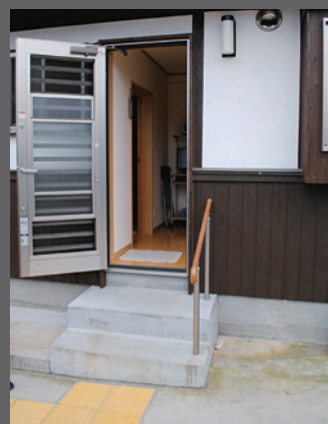
外から見た旧勝手口、条例により点字ブロックを敷設
