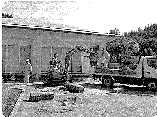
↑ “炭焼き窯”の側を整地して、ピザ窯の土台を設置していきます！ 本格的な作業です。↑
