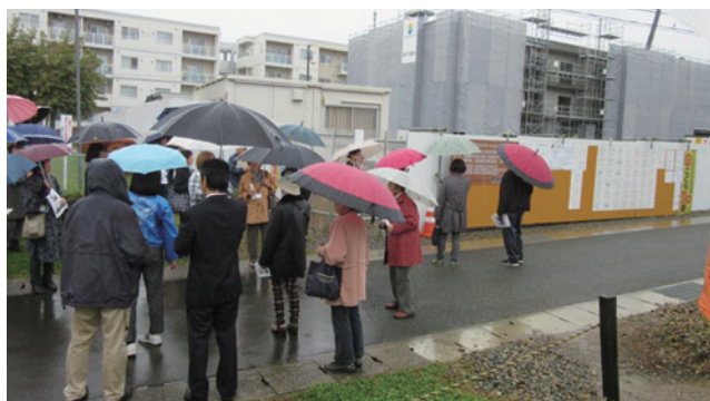
備後第1アパート建設見学会（2017/10/7）
