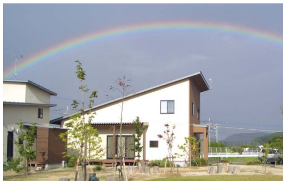
写真：子どもの村福岡のショートステイ専用棟
