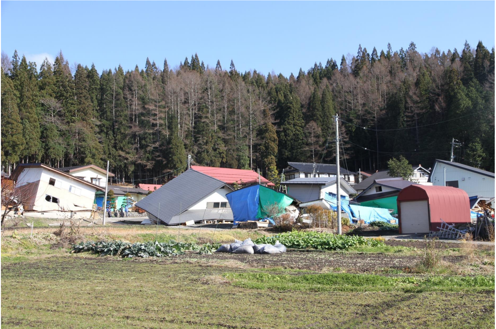
白馬村神城 堀ノ内地区における被害
