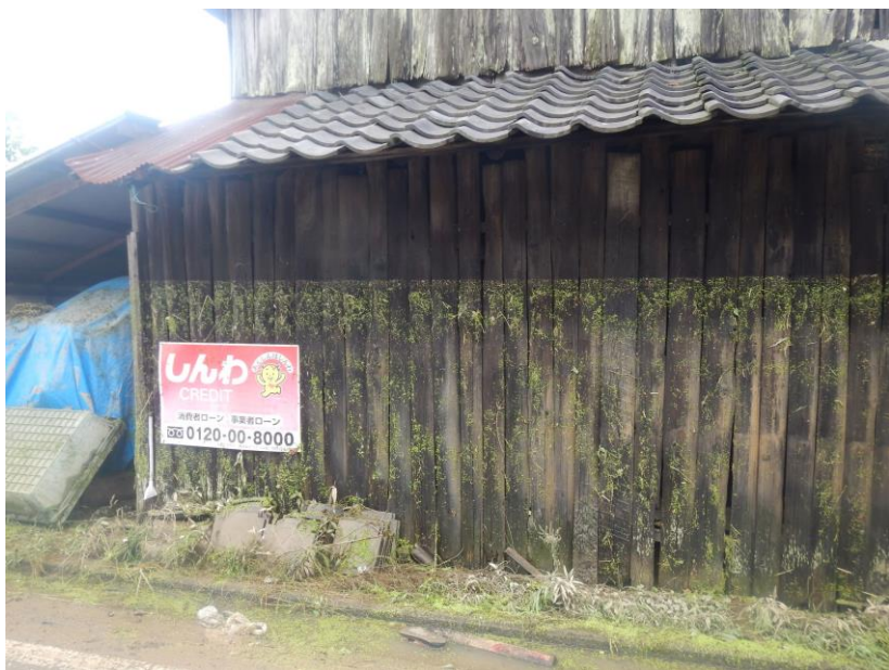
西日本豪雨 / 岡山県総社市
