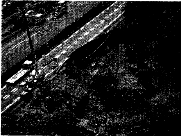
崩落する東名高速道路 (静岡県牧之原市)
