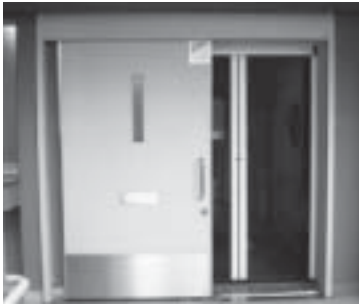
シルバーハウジング住居の玄関は、引き戸式で出入りしやすいようになっています。
