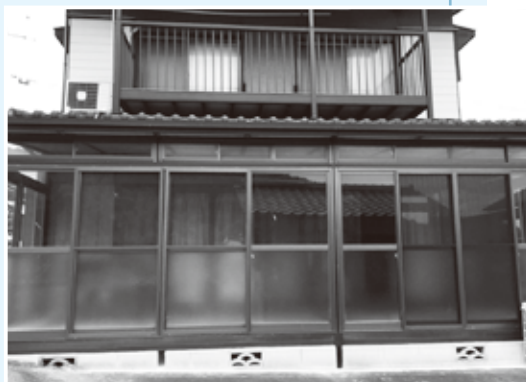
空き家を活用して開設したシェアハウス「ハーモニーはうす」。地域への想いのあるボランティアを募り、建物内の改修を行った
