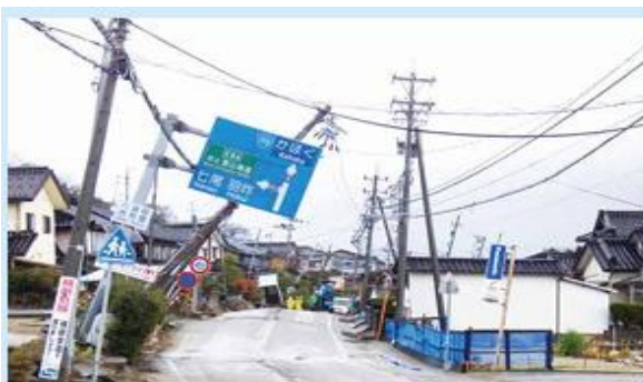
内灘町、かほく市等で 液状化現象による被害が発生
