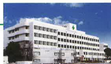
RKW 音羽病院 RAKUWAKAI OTOWA HOSPITAL
