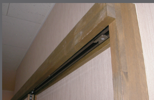
木製簡易上吊引戸の採用
