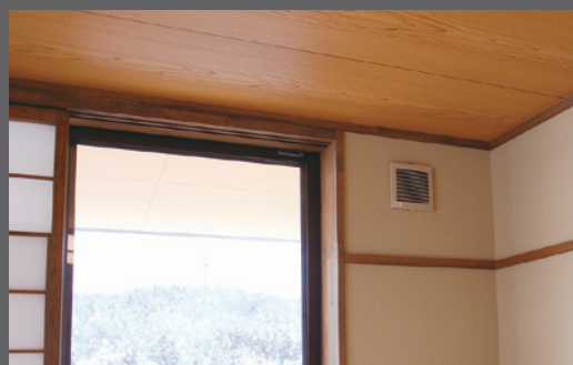
パイプファン採用のシンプルな空調システム
