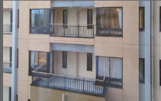
2つの居室で共有する避難バルコニー
