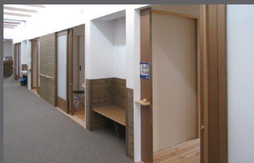
建具で壁面構成した路地風通路（特養）
