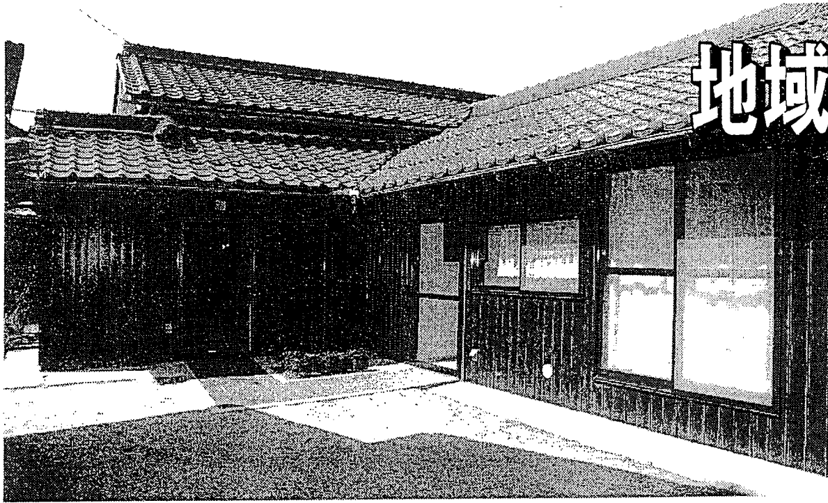
古民家を改修した「結の家」外観
