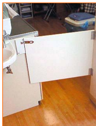
▲ 安全配慮(侵入防止の扉)
