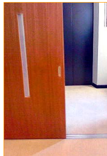
▲ エレベーター前の工夫 （木製の引き戸を設け、フロア全体に “住まい”としての温もりを与える…）
