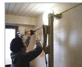
▲ 浴室に設置したリフト ◎入浴の楽しみの支援
