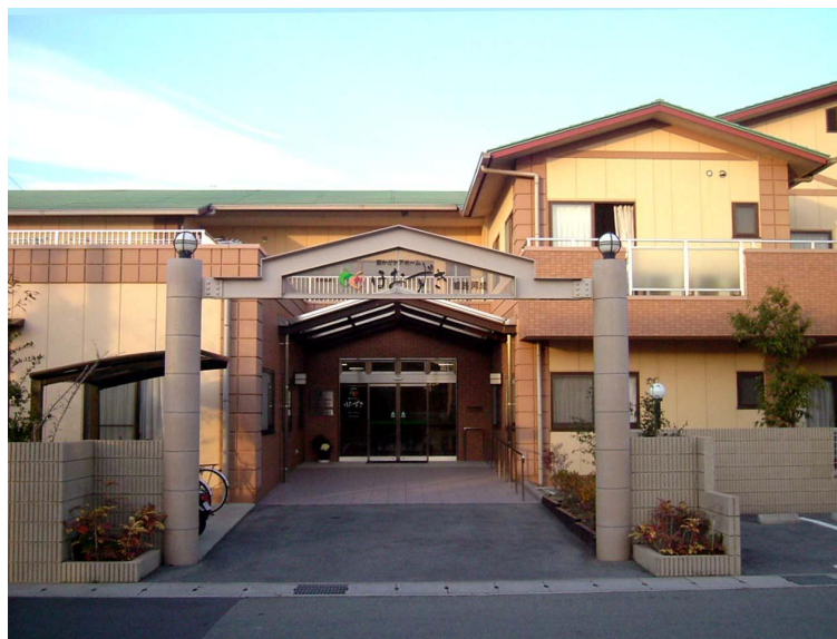
▼ホーム正面（玄関前には、屋根付きの駐車スペース）
